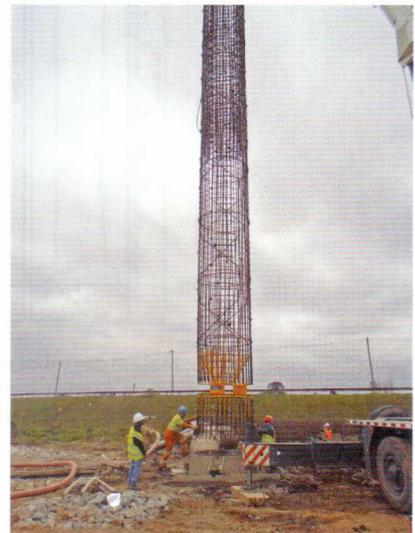
Fotos 1 (a) – Detalhe células-armadura finalizado e Foto 1 (b) – Descida do conjunto células-armadura
