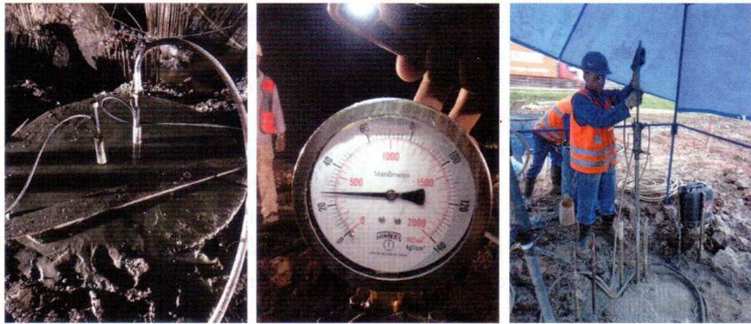
Fotos 3 (a), (b) e (c) – Injeção da calda de cimento para recuperação da estaca E25
