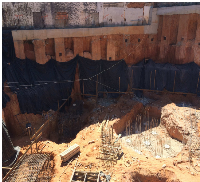
Figura 5 - Obra predial na cidade de Betim. Fonte - Autoras do artigo, 2015.
