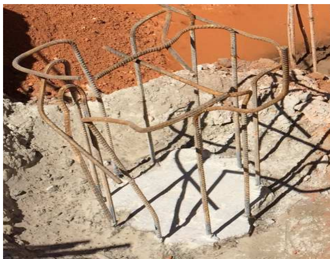
Figura 1 - Estaca após o arrasamento. Fonte - Autoras do artigo, 2015.
